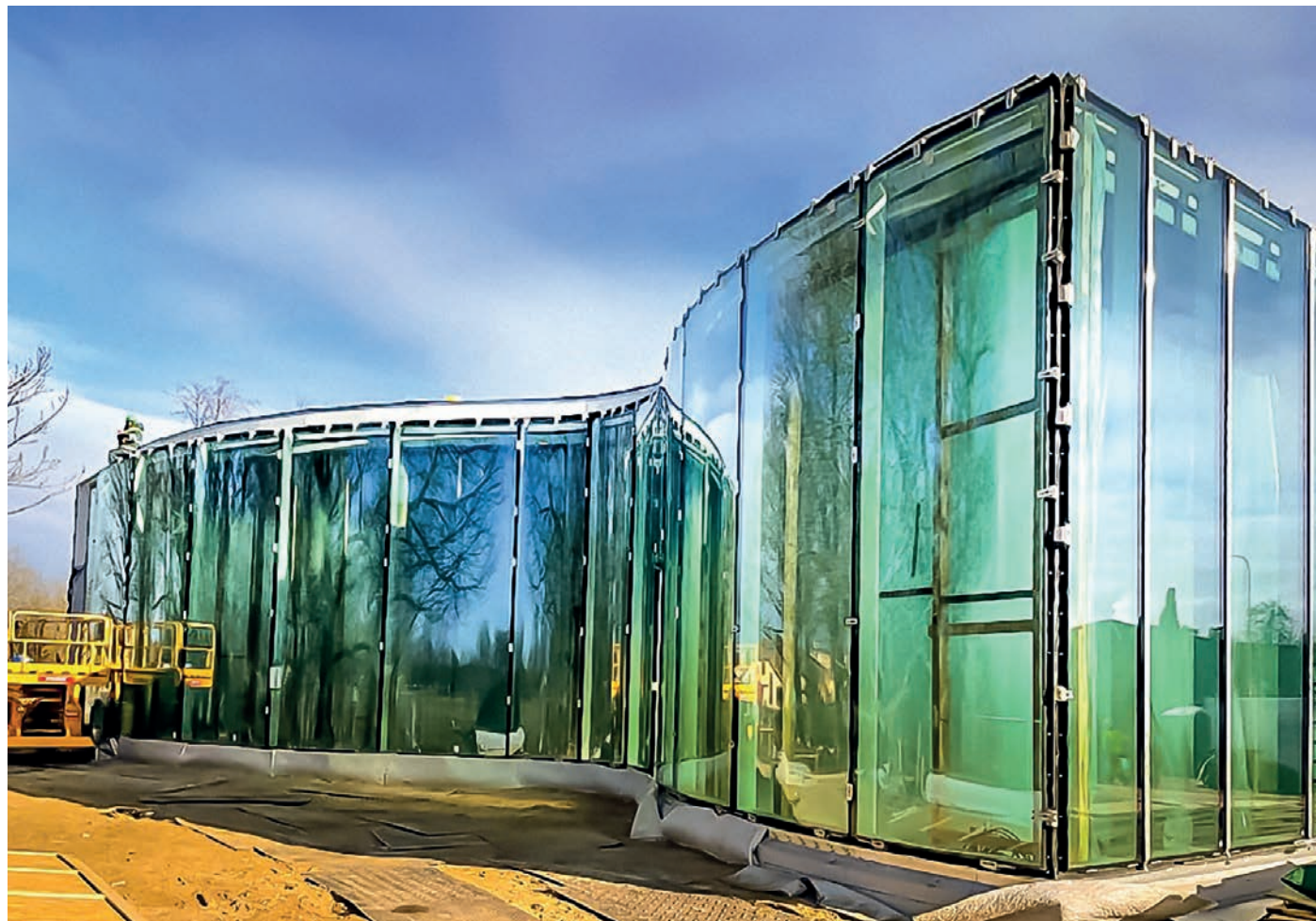
Montering av fasaden på Galinciems-biblioteket i Ventspils (Latvia) ved hjelp av Heavydrive VSG 1500 KR MH sugesystem for buede ruter.
