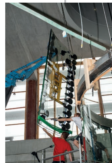
MRK 144.0 S-monteringskranen og VSG 1000 KR vakuumsugesystem som brukes til glaserings av flykammeret
