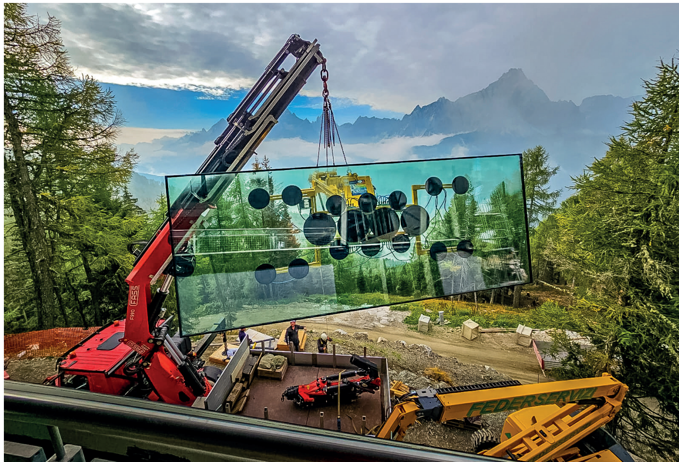
Ruten løftes inn i den skrånende fasaden ved hjelp av Heavydrive-systemet.
