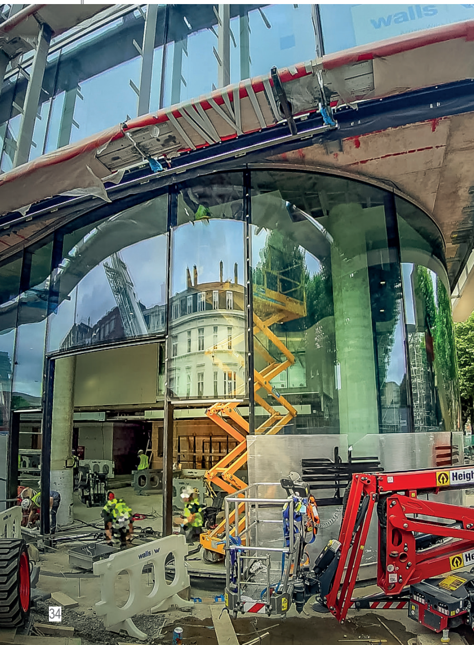
Innglassing av ulike konkave og konvekse ruter under et utstikk
