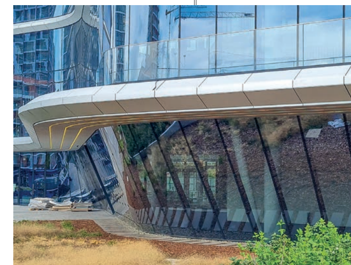
Heavydrive-opppdrag på MOL Campus i Budapest: Montering av de utadgående rutene.
