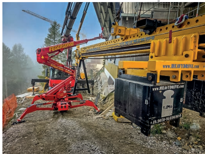
Ruten løftes inn i den skrånende fasaden ved hjelp av Heavydrive-systemet.
