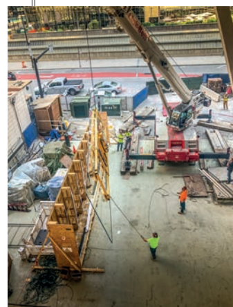
Ruten løftes bak søylen med modifisert glassmonteringsutstyr
