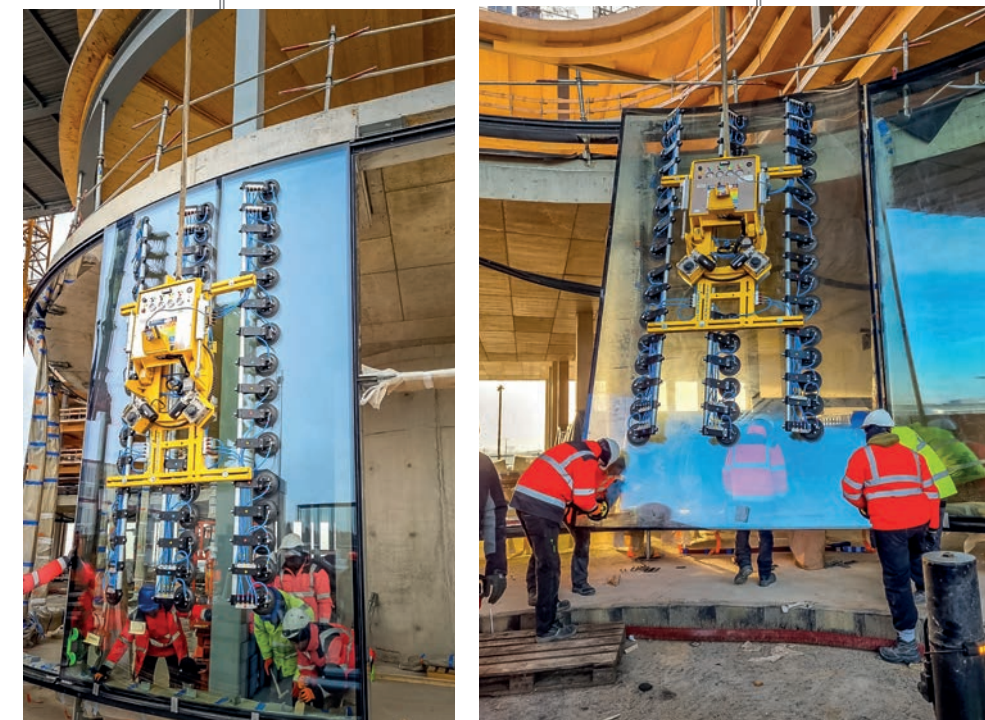
Plassering av de buede rutene ved hjelp av sugeløfteren
