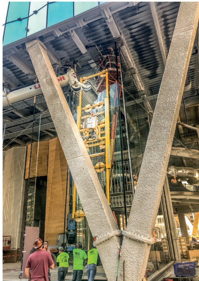
Ruten løftes bak søylen med modifisert glassmonteringsutstyr
