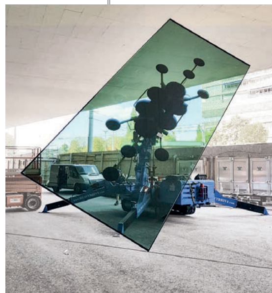
Glassmontering under et overheng med VSGU 1500 KMH
