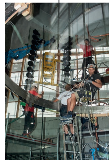
MRK 144.0 S-monteringskranen og VSG 1000 KR vakuumsugesystem som brukes til glaserings av flykammeret
