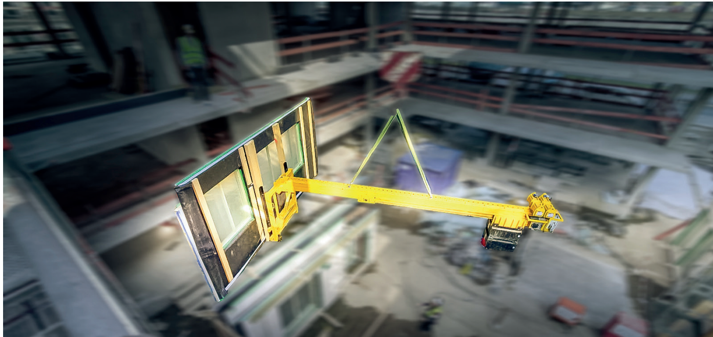
Plassering av fasadeelementene med VSG motvektsbjelke og spesialutviklet gaffel.
