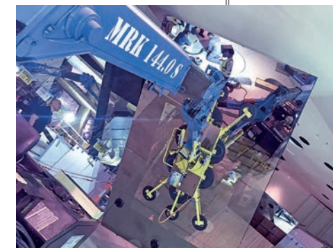
Den var ekstremt manøvrerbar og allsidig, og klarte å plassere alle rutene med millimeterpresisjon, samtidig som den beskyttet gulvet og produserte null utslipp.
