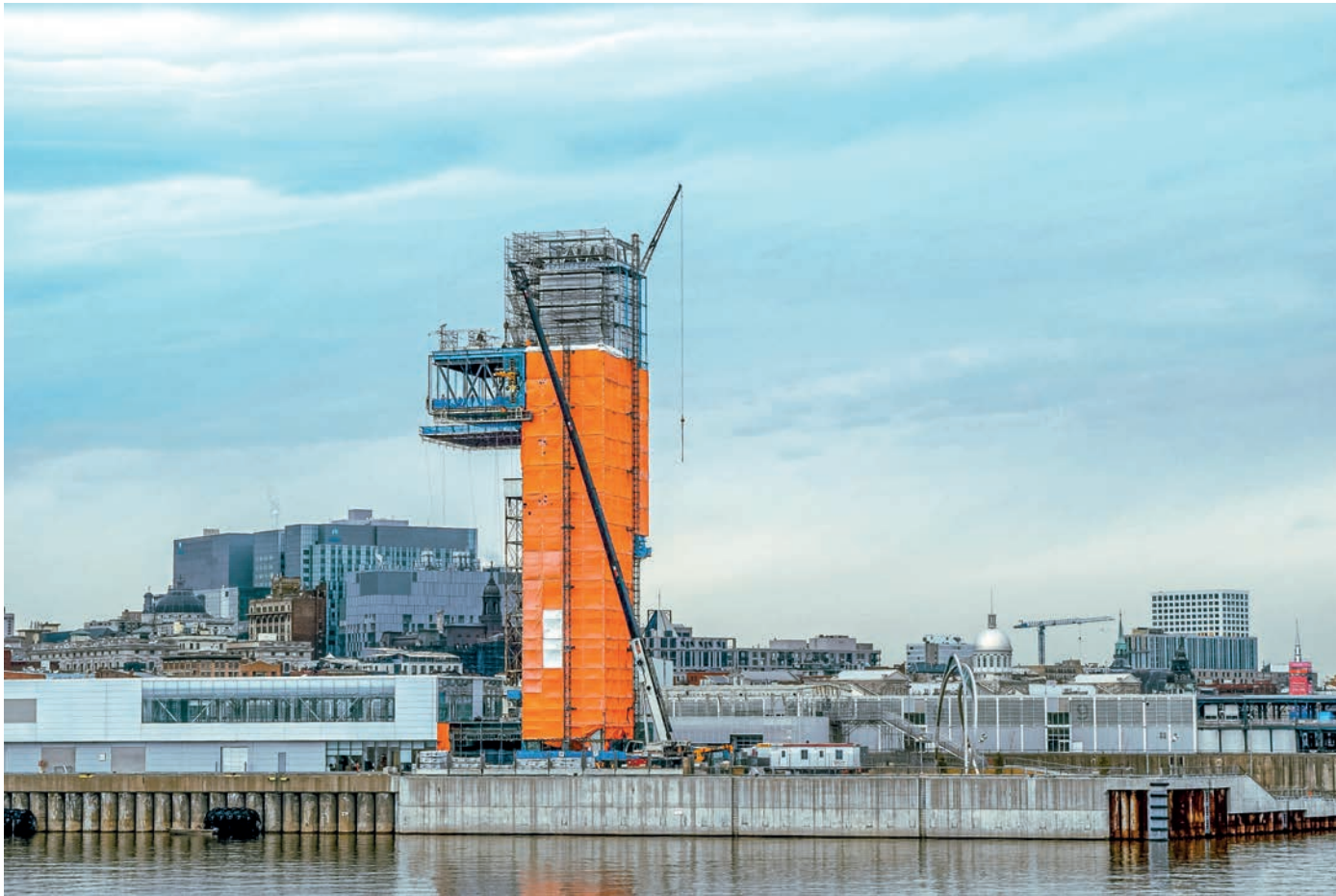
Heavydrive glassinstallasjon i Grand Quay-tårnet i Montreal i Quebec (Canada).
