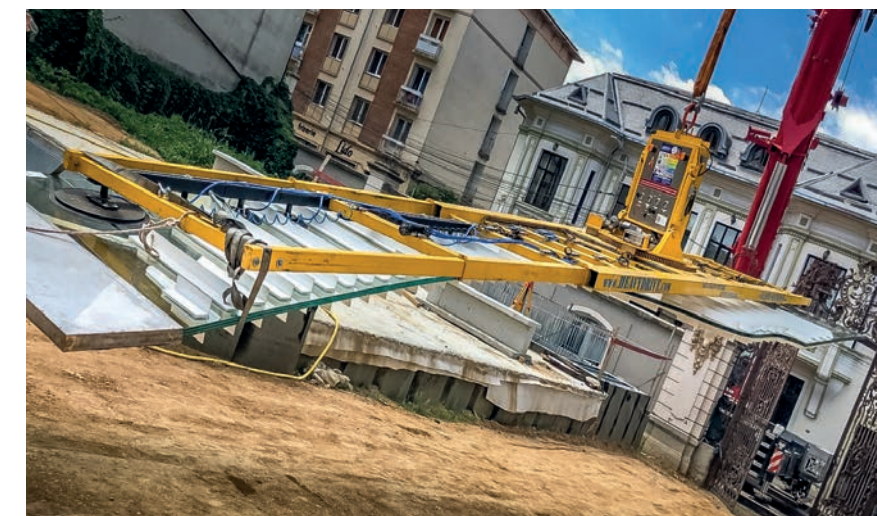
Heavydrive-systemet transporterer 12,5 meter høye designruter med bølgede kanter. Bilderrettigheter: montec-gmbh.de
